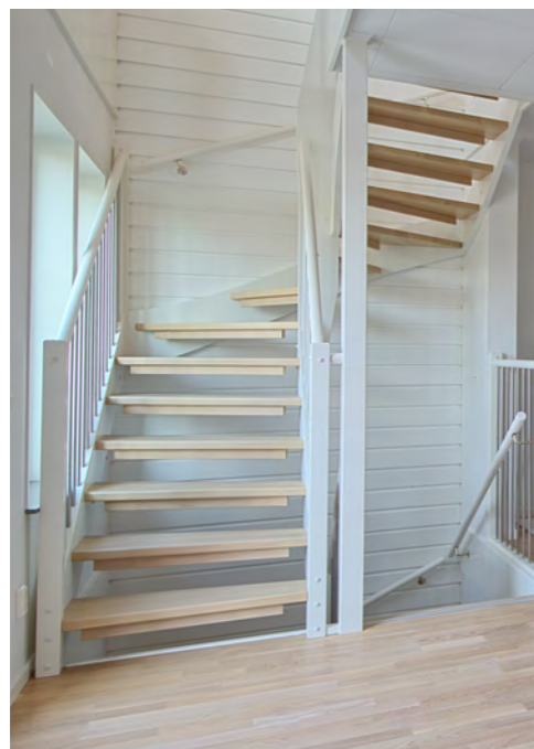
Öppen trappa (2 st i radhus med loft) Furu med vit vang inkl. stegskydd, plansteg i ek, färganpassad till Ek Concerto. Vitmålad avtäckningsbräda till bjälklagskant Vitmålad handledare typ Funk 11 (spjälor av metall)
