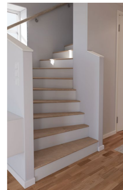
Trappa Tät furutrappa med vitmålad sättsteg och vang. Plansteg i ek laserade enligt golvet Lecco. Handledare typ Funk i ek mattlack färganpassad till golvet Lecco.
