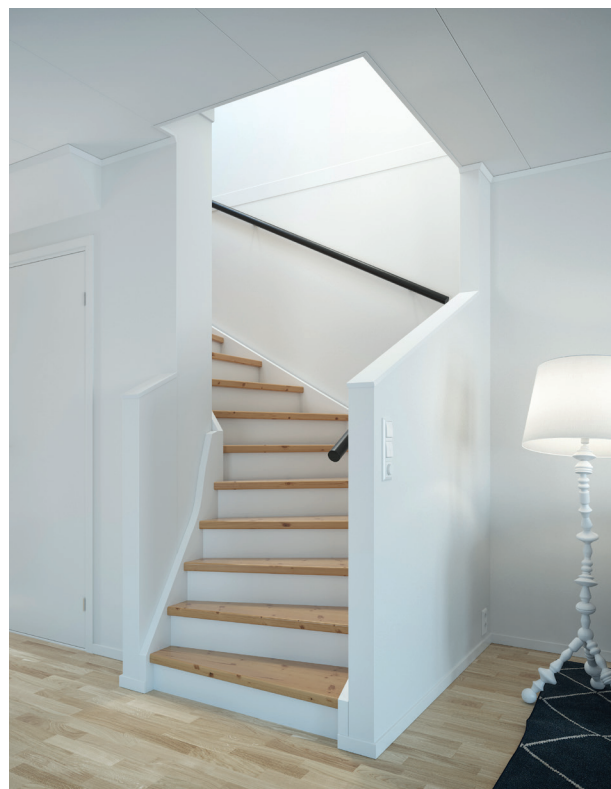
Tät trappa med plansteg i eklaserad och klarlackad furu med vitmålade sättsteg och vang. Handledare typ Funk i svartlaserad furu.
