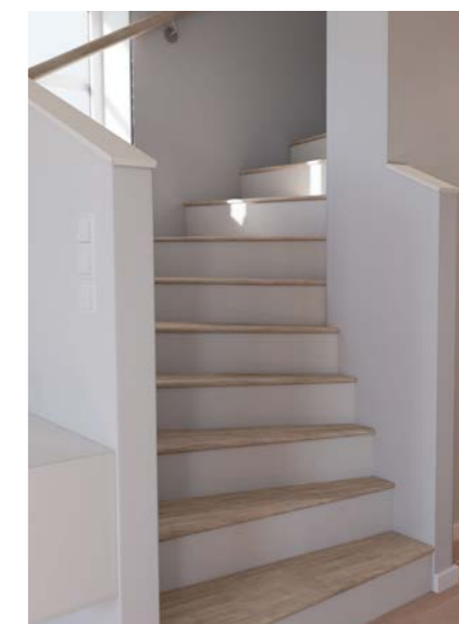
Trappa Tät trappa inkl. vang och sättsteg i vitmålad furu (NSC S 0500-N). Plansteg, handledare och räcke i eklaserad och klarlackad furu.
