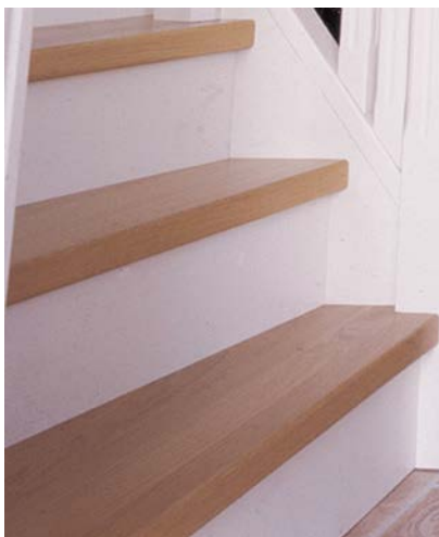
Tät trappa i alla hus förutom 213. Plansteg, sättsteg och rund handledare i ek. Vit vang och bjälklagsinklädnad.
