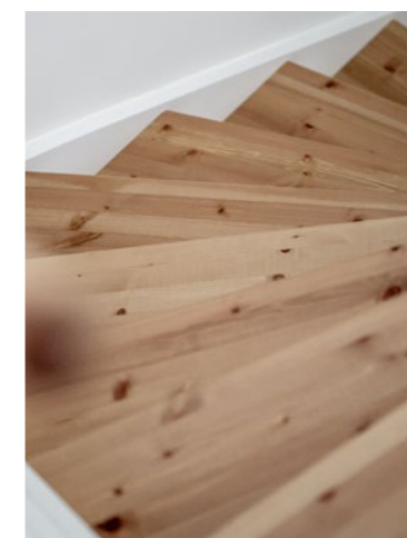
Tät trappa Vang och sättsteg i vitmålad furu. Plansteg i furu eklaserade. Handledare i eklaserad furu, typ Funk 11.
