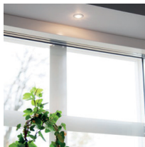
Spotlights fönster Placeras i fönstersmyg i matplats, vardagsrum och kök.
