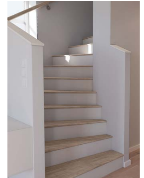
Trappa Tät trappa inkl. vång och sättsteg i vitmålad furu (NSC S 0500-N). Plansteg, handledare och räcke i eklaserad furu, typ Funk 11 (spjälör av metall)
