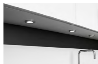
Spotlights under väggskåp
