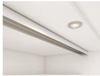
Infällda spotlights under väggskåp
